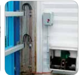
Centralina idraulica MEC 700/80 VENTIL con doppio serbatoio all'interno dell'armadio di protezione
